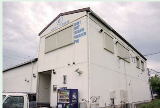
茂原工場外観
